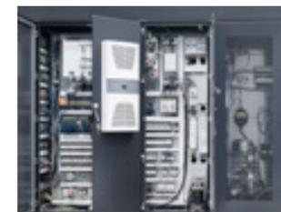
Leicht zugänglicher, klimatisierter Schaltschrank.
