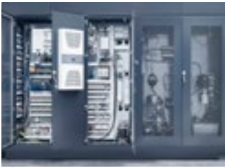
• Armoire électrique climatisée et facilement accessible. • Centrale programmable Système de graissage. (Standard)
